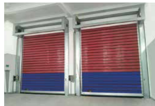
■ 大连机场消防
