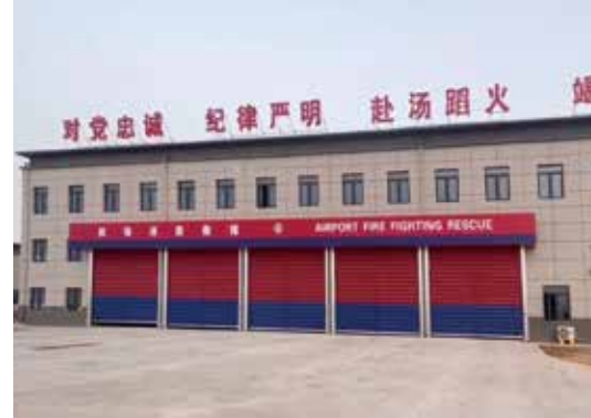
咸阳机场消防站
