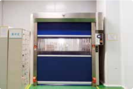
无尘洁净车间
